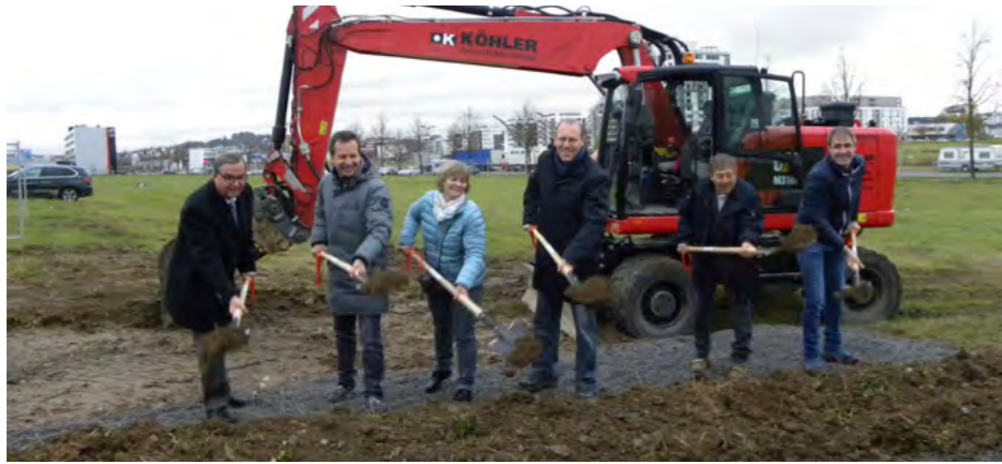
Mit dem Spatenstich am 8. November 2017 startete der Neubau für die innovaphone AG im Gewerbegebiet Am Wall.
