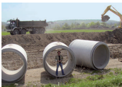
Den Erschließungsarbeiten folgt schon bald der Hochbau.
