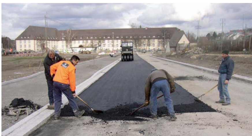
Vom Wetter begünstigt: die Straßenbauarbeiten machten schnelle Fortschritte.
