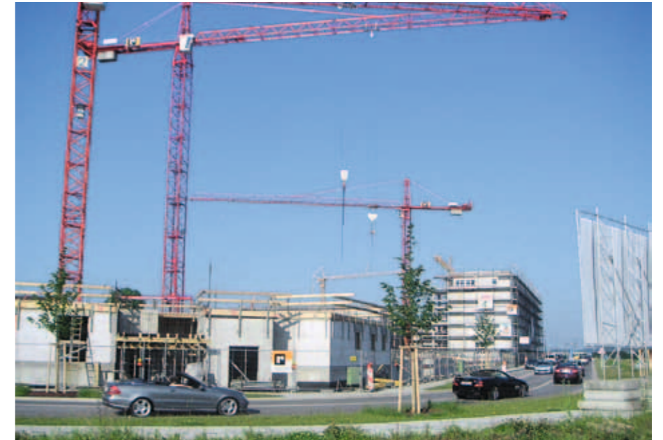
Das Flugfeld wächst in die Höhe: Die Hochbauphase ist deutlich erkennbar.
