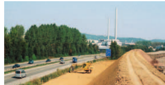
Der ca. 2 km lange Wall verläuft zwischen Flugfeld und Autobahn.
