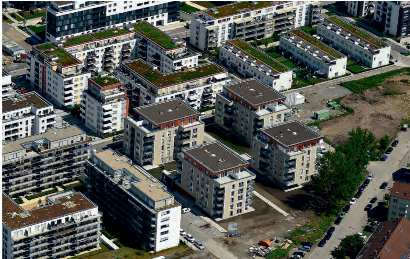
Eigentums- und Mietwohnungen wurden im zweiten Bauabschnitt 2013 fertiggestellt.
