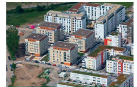
Aktuell im Bau: 54 Eigentumswohnungen
