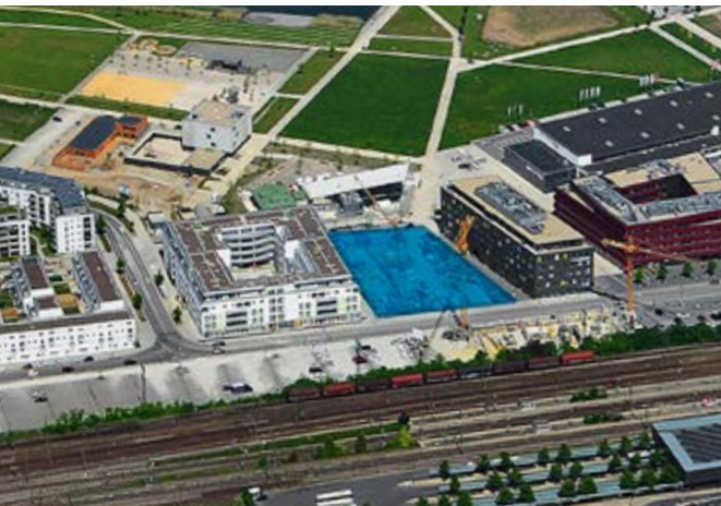
Das Baufeld der Micro Apartments befindet sich zwischen dem Medicum (rechts vom Baufeld) und dem Pflegezentrum (links davon).
