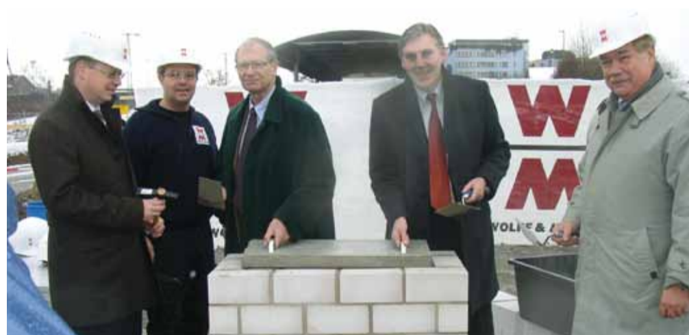
Grundsteinlegung Parkhaus. V.l.n.r. Thomas Drexel (Wolff & Müller), Stefan Schott (Wolff & Müller), OB Alexander Vogelgsang; EBM Helmut Riegger, Olaf Scholz
