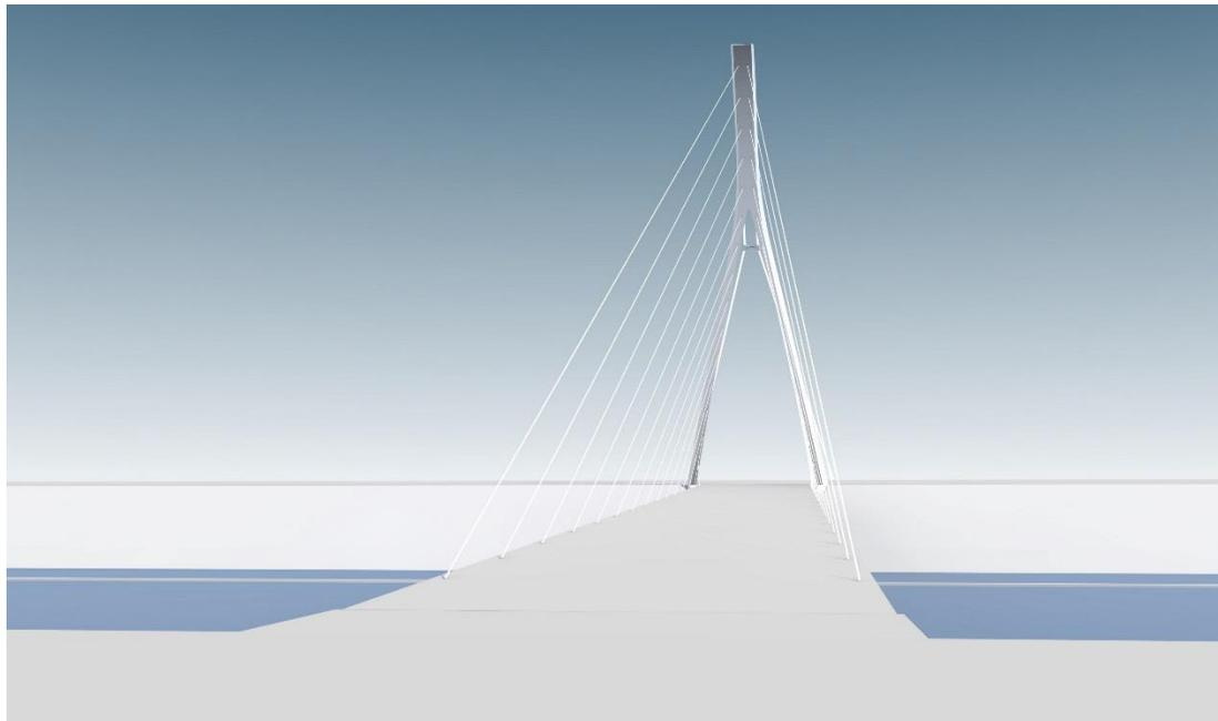
Die Variante 9 ist eine rückverankerte einhüftige Harfenbrücke. Durch die Kürzung des Mastes ist nur eine Abspannung, die tangential in die Mastspitze einläuft, nötig. Der Überbau besteht aus Längsträgern, die die axiale Kraft aus den Schrägseilen "auf sammeln" und mit der Horizontalkomponente der Abspannung "kurzschließen", sowie Querträger, die die Betonplatte tragen. Die Seile werden aus offenen Spiralseilen und verstellbaren Gabelfittingen hergestellt.
