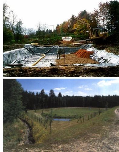
**Abbildung 2: Gestaltungsbeispiele Regenwasserreinigungsanlagen**
