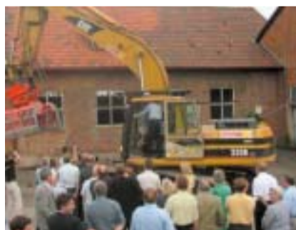
Historischer Moment: der erste Baggerbiss
