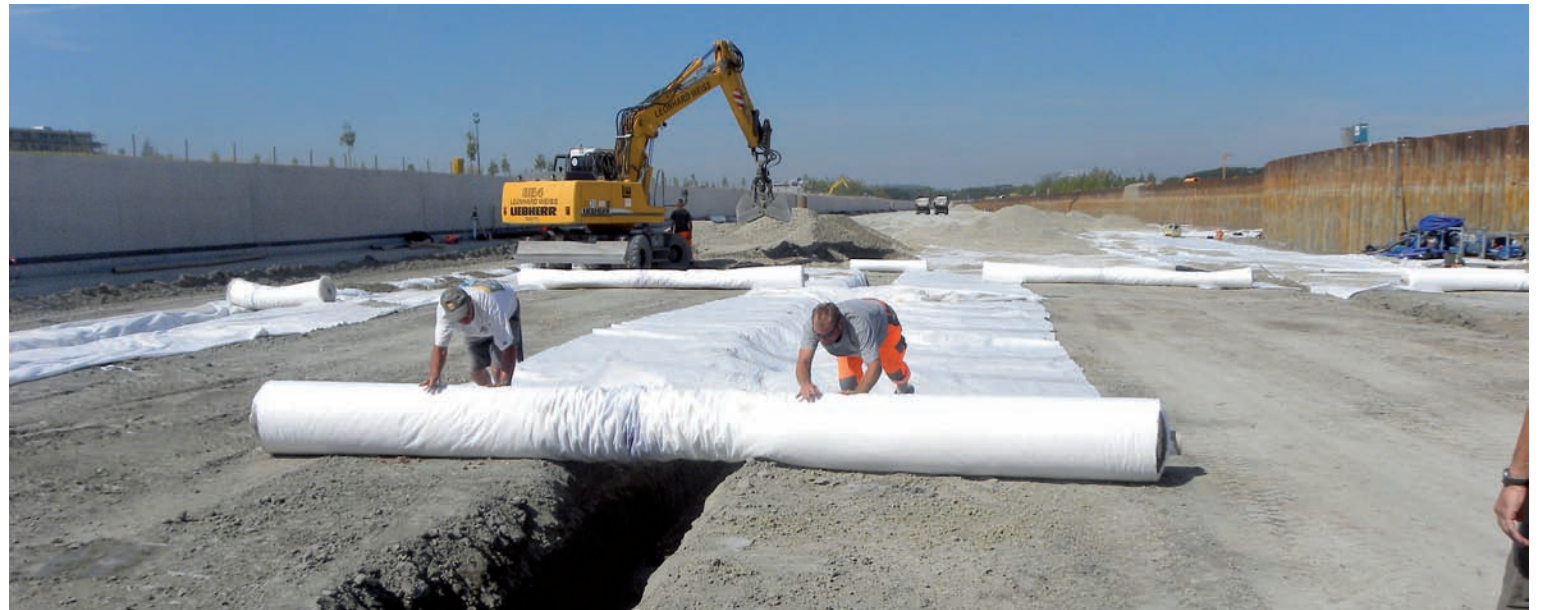
Damit die „Wanne“ voll bleibt: Dichtungsarbeiten an der Seesohle
