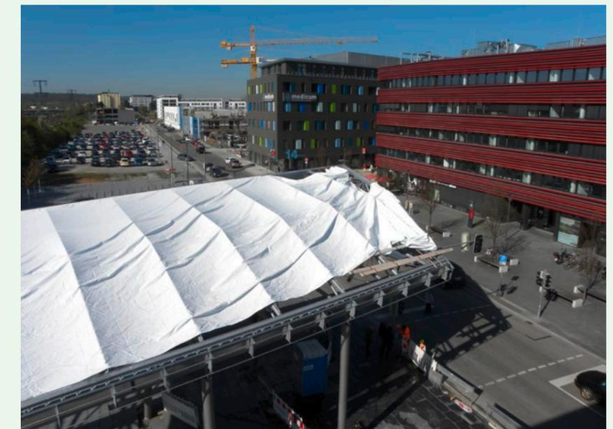
Die leichte Dachbespannung wird angebracht und bietet Schutz vor Sonne und Regen.
