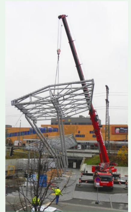
Ein Schwerlastkran hebt die Stahlkonstruktion in die richtige Position.
